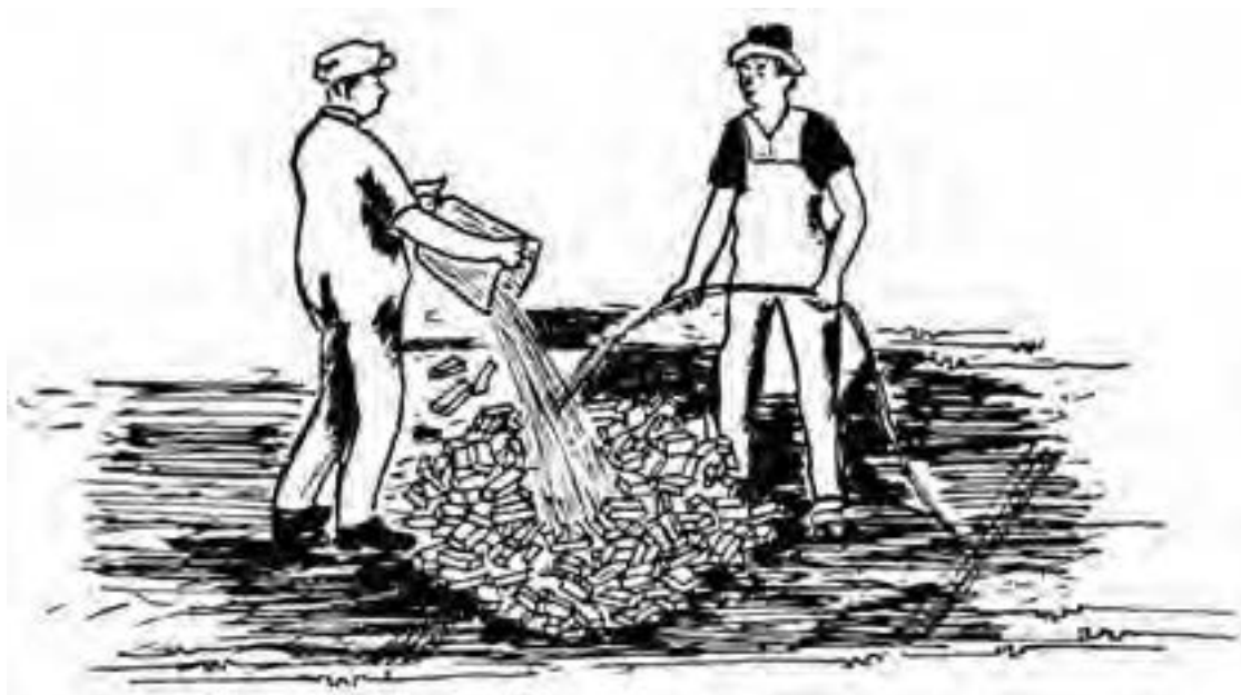
شکل ۳۷ ▲ زنجاب کردن آجر
