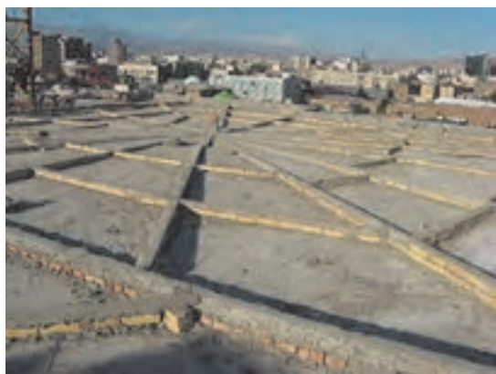
شکل ۱۴ ▲ کرم‌بندی و شمشه‌گیری بین آن‌ها
