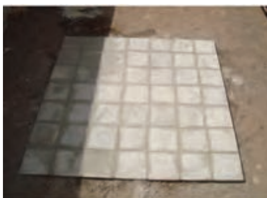
شکل ۲۶ ▲ سطح پاک‌شده کار
