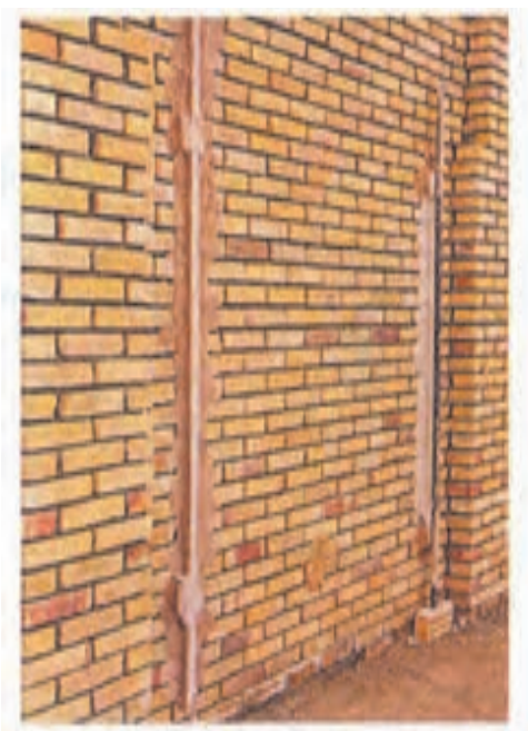
شکل ۲۳ ▲ شمشه‌گیری بین کرم‌ها
