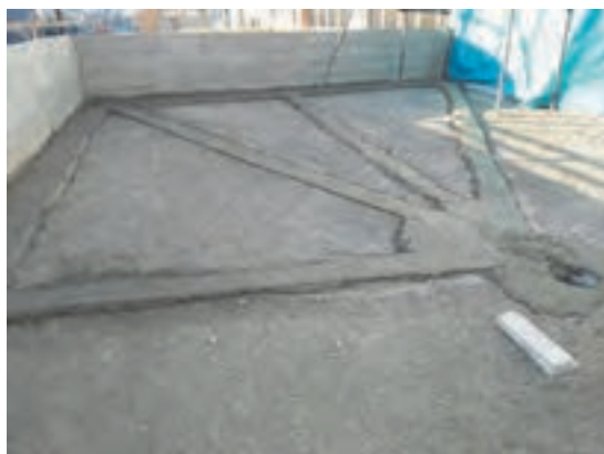
شکل ۱۴ ▲ کرم‌بندی و شمشه‌گیری بین آن‌ها
